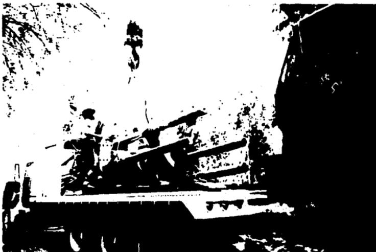
Foto 12. Sujeción del marco de carga para descargarlo del camión.
