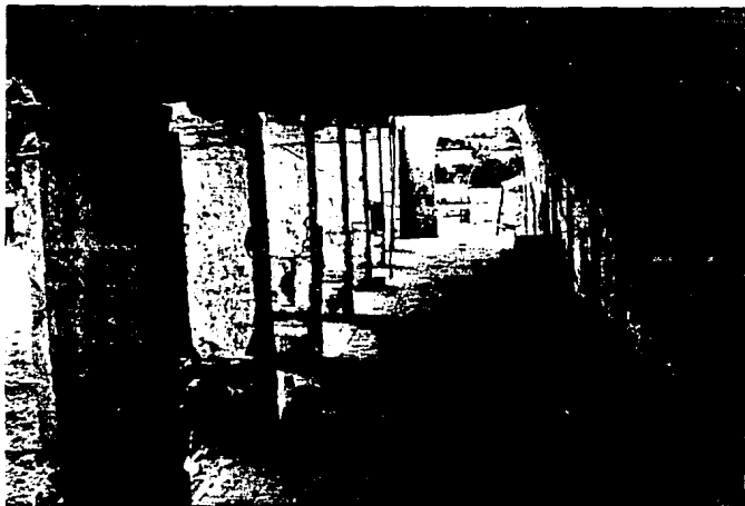
2.- Portal norte visto de oriente a poniente (28-III-82, P.R.)
