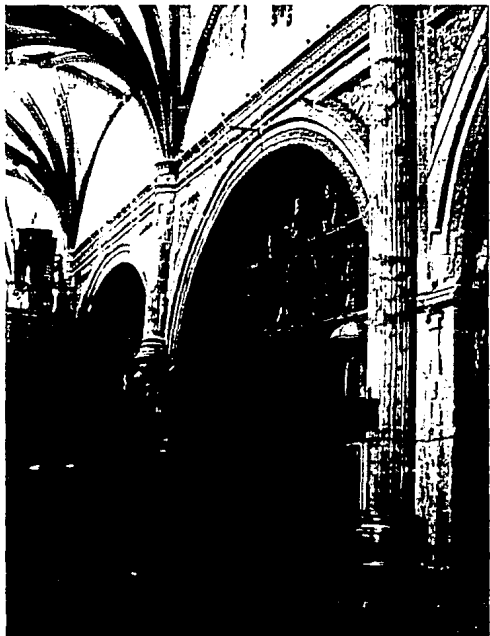
97.- Vista del interior del templo hacia el coro y acceso lateral. Observar que ya están encajados los plementos de las bóvedas -desde 1980-, debió obedecer a una unificación de la obra de resane (30-I-82, P.R.)
