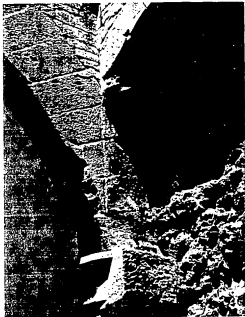
7.- Interior del arco frontal y vista del material de relleno (29-III-82, P.R.)
