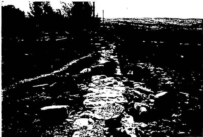
23.- Porción derruida de la barda del atrio (poniente), en donde se ve que el núcleo fue hecho con piedra labrada (30-I-82, P.R.)
