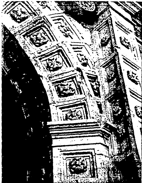
64.- Detalle, jamba, arco y pilar entablerados y con flores, entre estas últimas se destacan las de tres pistilos, en uno de los lados que flanquea el acceso (28-III-82, P.R.)
