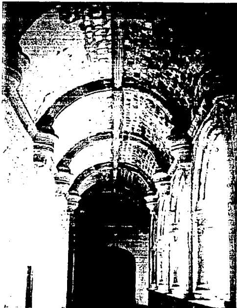
121.- Corredor norte, acceso a un confesionario y al fondo a la antesacristía. Ménsulas, primera piedra de arranque de los nervios transversales (15-IX-75, P.R.)
