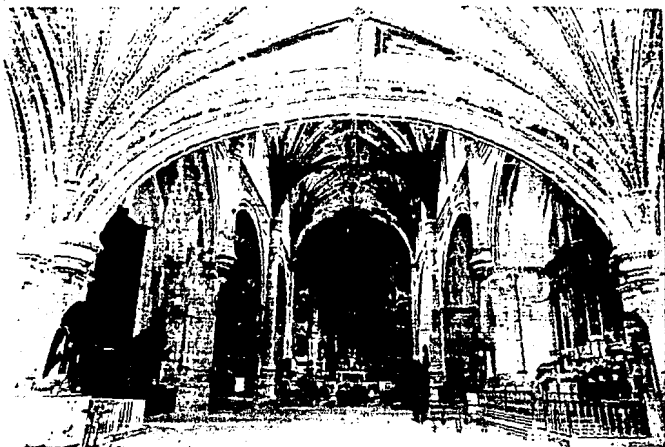
94.- Interior del templo desde el sctocoro . Observar que los plemen- tos de la bóveda del templo, ya no tienen completa la pintura (14-IX-75, P.R.)
