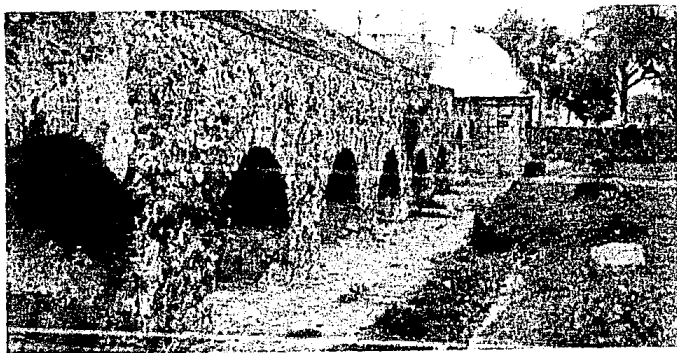
ACUEDUCTO DE ARCOS UBICADO AL NORTE DE LA CIUDAD DE MEXICO.
