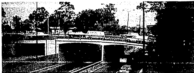
PUENTE UBICADO EN VIADUCTO Y AVENIDA DE HULE.
