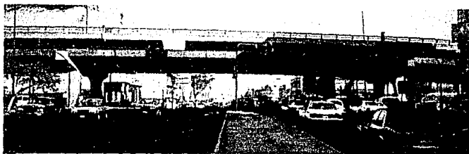
Tipo de estructuración:- Isostáticos.
