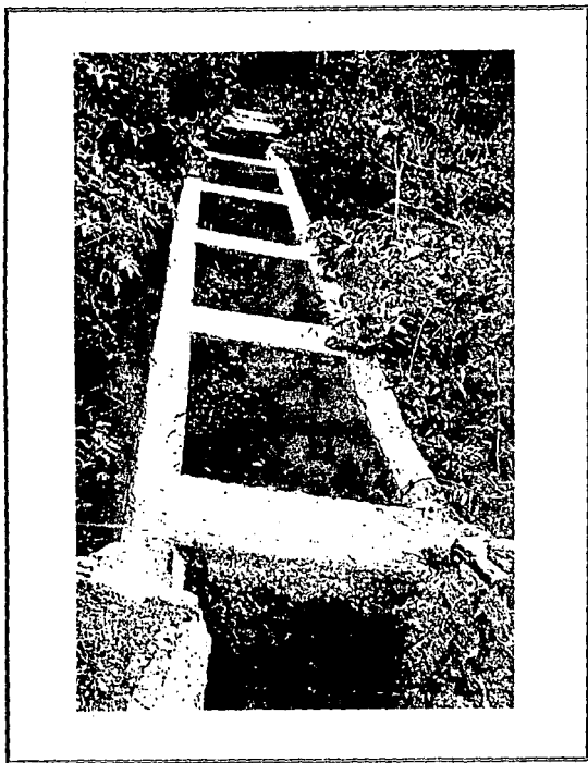
FOT. No. 8.- Puente canal ubicado en el cadenamiento km 0 + 689, de la alternativa El Sauz I-C. Esta fotografía fue tomada del canal aguas arriba.
