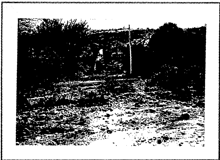
FOT. No. 11.- Descarga del A. Inuco al R. Iiquilpan, el cauce de este arroyo esta borrado, es prácticamente la calle, en la cual se ha construido un pequeño bordo (para evitar el desbordamiento del R. Iiquilpan). Esta fotografía fue tomada de la margen izquierda del río hacia aguas arriba de arroyo.
