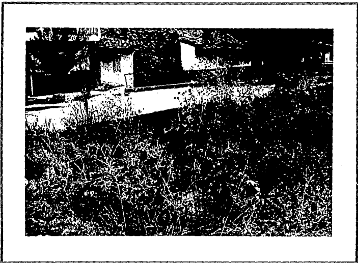
FOT. No. 19.- Puente alcantarilla de la calle San Bartolome de las Casas; se puede apreciar claramente que el cauce del arroyo El Sauz, esta cubierto por hierba y pequeños arbustos. Esta fotografia fue tomada sobre la margen izquierda del arroyo El Sauz aguas arriba.
