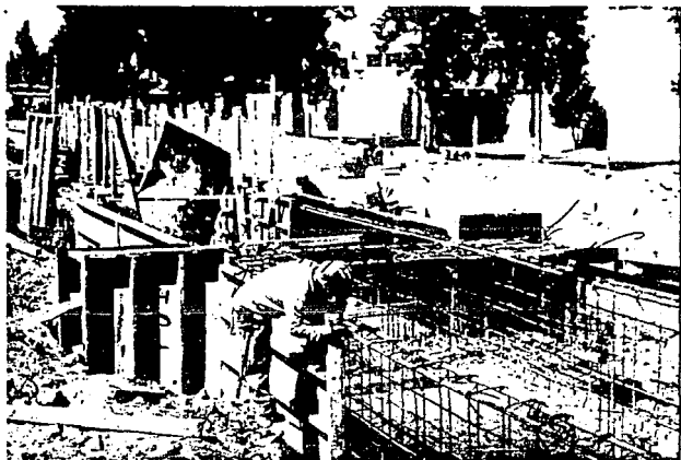
FOTO 1 SE MUESTRA ARMADO DE CANDELERO INTEGRADO A LA CIMENTACION, PARA COLAR MONOLITICAMENTE AMBAS ESTRUCTURAS
