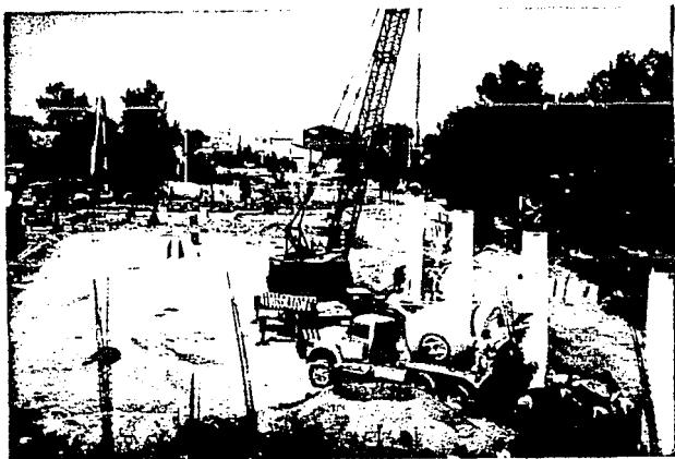
FOTO 2 ANCLAJE DE COLUMNAS PREFABRICADAS Y COLOCACION DE CONCRETO ESTABILIZADOR EN CANDELEROS.
