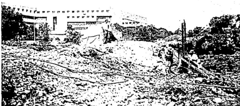
FOTOGRAFÍA 4.1 Equipo de perforación Stenuick
