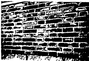
Fig. 2.10 Salitre, caso particular de efloroscencias
