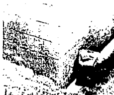
Fig. 4.16 Aplicación de material sellador o repelente
