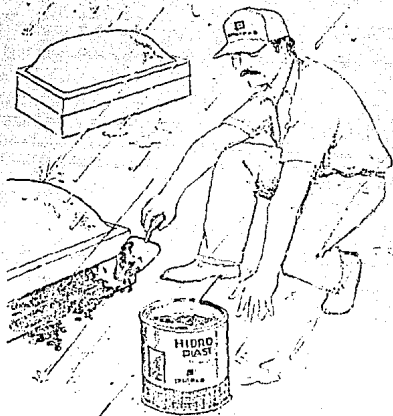
Fig. 4.7 Preparación de bases para tragaluces y domos
