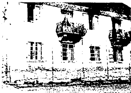
Fig. 2.6 Efectos de la ascensión del agua del subsuelo por capilaridad
