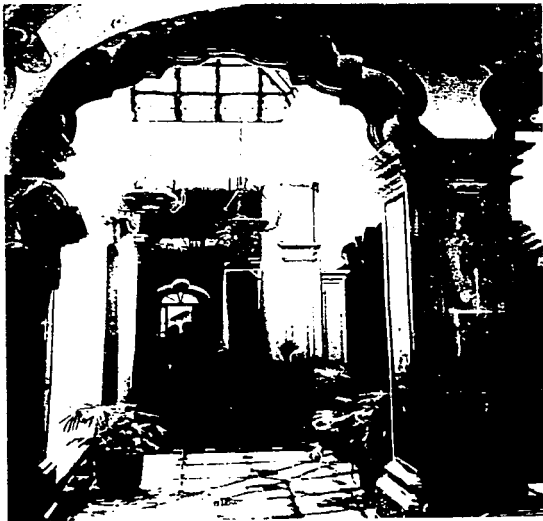
FIGURA No. 35 Arcos en la planta alta de la casa de "la marquesa" en Querétaro. FOTO: G. Boils, 1987.
