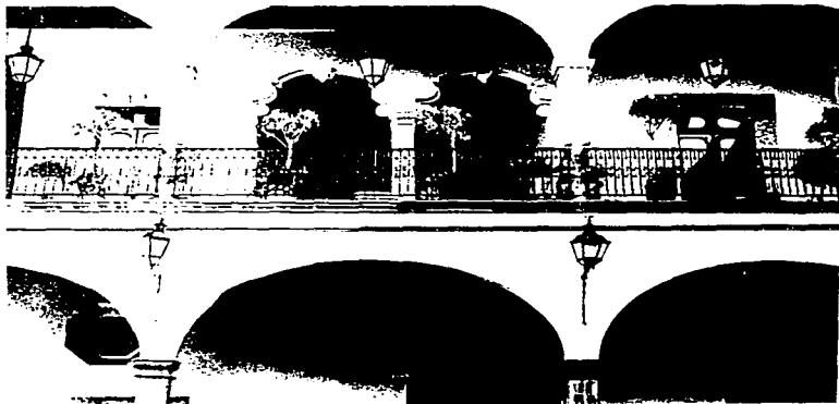
FIGURA No. 46 Arcos en el desembarque de la escalera (arriba-centro) del edificio de las casas reales en Querétaro (1770)
