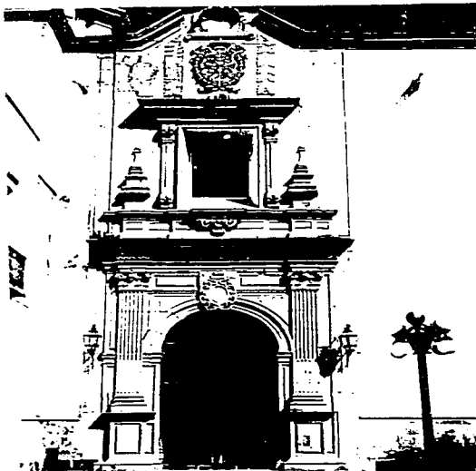
FIGURA No. 19 Portada Suroeste de la iglesia de Santa Clara, Querétaro (fines siglo XVII, reacondicionada en el XVIII). FOTO: G. Boils, 1989.
