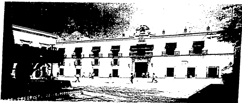
FIGURA No. 305 Fachada principal (Sur) del edificio de las casas reales de la ciudad de Querétaro (Actual palacio de gobierno del estado). FOTO: G: Boils, 1989.
