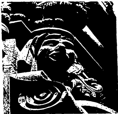
FIGURA No. 276 Detalle ornamental en una columna en la parte baja de San Agustín, Qro. FOTO: G. Boils, 1989.
