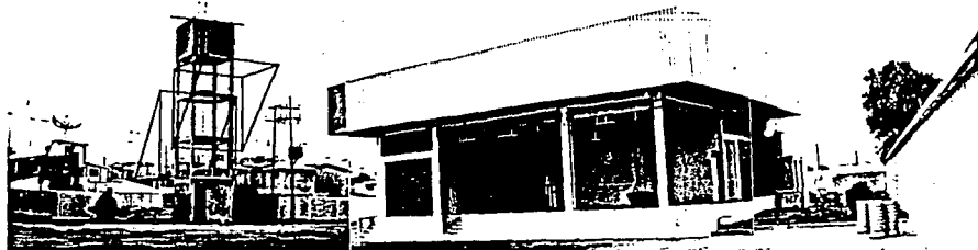
VISTA DE TANQUE ELEVADO Y VENTA DEL PRODUCTO PROCESADO
