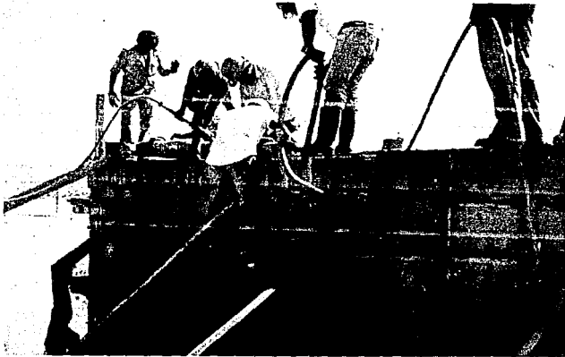
Utilización de Cimbramex como cimbra
