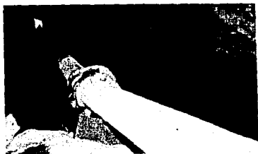
Foto 18; Ranuración de bóveda, so- porte de la tubería y confinamiento- "tapón" para cubrir totalmente los ti- rantes altos y que presentan pendien- tes inversas al flujo de mezcla.
