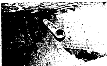
Foto 17; Trabajos requeridos para -- garantizar el relleno de túneles dis- tantes y topográficamente altos, -- donde fue preciso utilizar el bombeo.
