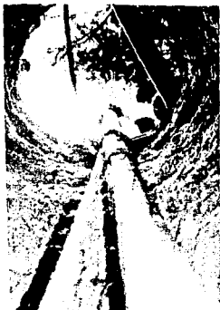
Foto 16; Introducción de la tubería que será utilizada para bombear la mezcla; método utilizado por no ser posible evitar este concepto.
