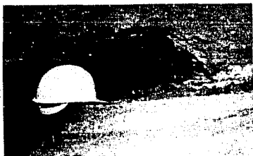
Foto 26; Flujo de mezcla proveniente de un barreno donde fue inyectada la mezcla dosificada y que al obtenerse no se logró el objetivo trazado.
