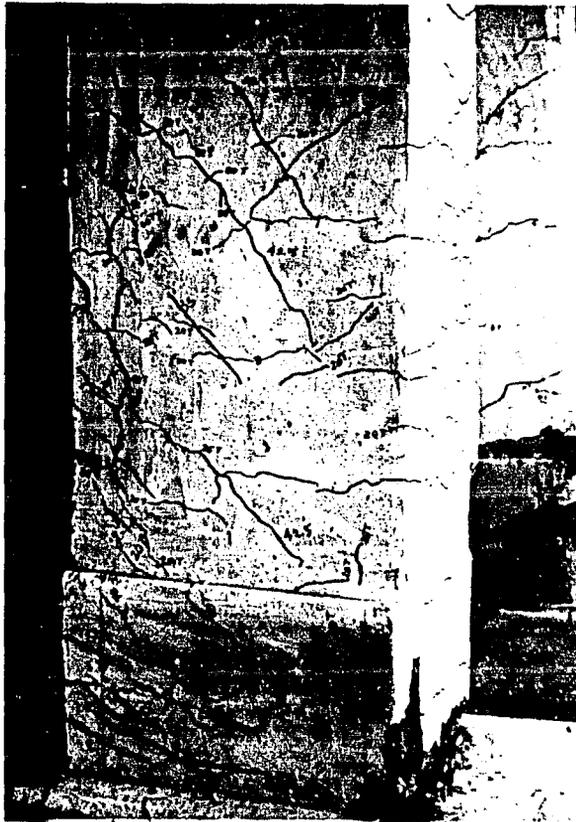
Fig. 3.49 Vista de grietas en la zona de momento positivo,
