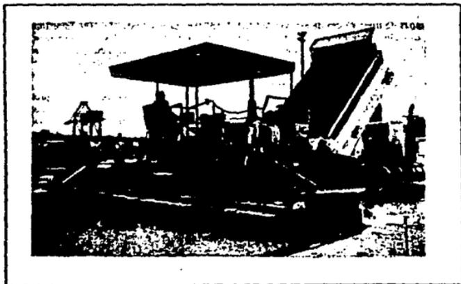
FIGURA 5.1. UN CAMION DESCARGA MEZCLA RIGIDA EN LA PAVIMENTADORA EQUIPADA CON LLANA VIBRATORIA DE TRABAJO PESADO.
