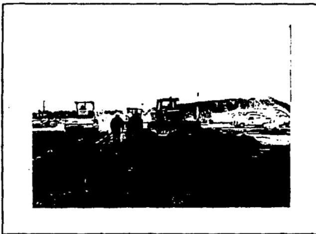
**FIGURA 2.4. NIVELACION Y EXTENDIDO DEL C.C.R. EN UNAS VIAS DE FERROCARRIL EN BURLINGTON, NORESTE DE HOUSTON.**
