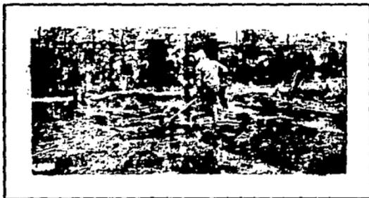
FIGURA 2.14. CURADO DEL C. C. R. CON ARENA HUMEDA.
