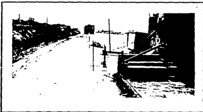
FIGURA 4.19. SUB-BASE ESTABILIZADA CON CEMENTO.
