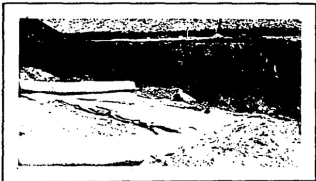
**FIGURA 4.18. TENDIDO DEL ANTICONTAMINANTE DRENANTE.**
