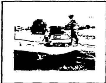
**FIGURA 4.25. ASERRADO DE JUNTAS
