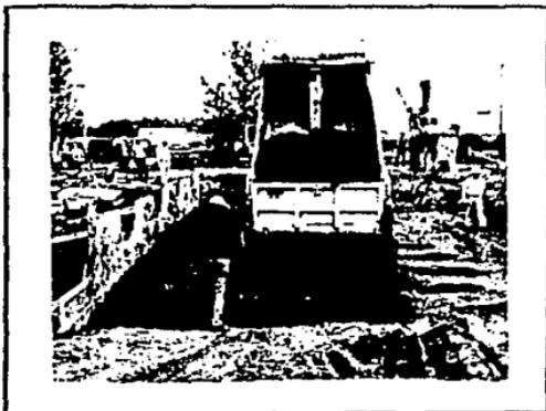
FIGURA 3.10. TRANSPORTE DEL C.C.R. EN EL BORDO DE PRUEBAS EN WILLOW CREEK.
