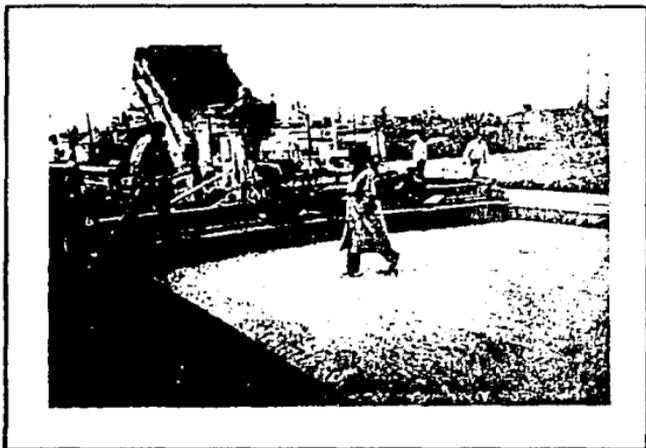
FIGURA 2.18. CAMION DESCARGANDO SOBRE UNA PAVIMENTADORA
