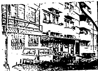
Otra vista de los edificios que componen la calle de Martires de la Conquista (3)
