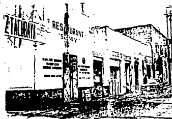
Se puede apreciar que la calle de Martires de la Conquista esta compuesta de comercios (4)
