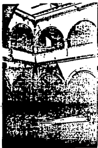
GRAFICA DONDE SE MUESTRA EL INTERIOR, EL PATIO CENTRAL DEL CLAUSTRO
