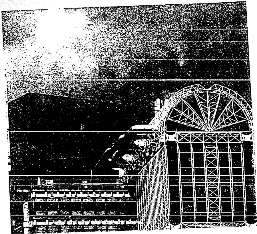
F.54. Lloyd's. Vista del edificio principal, distinguiéndose el atrio a la izquierda.
