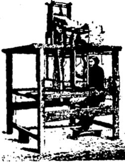
El telar de Jacquard usaba un sistema de tarjetas perforadas para tejer patrones automáticamente.
