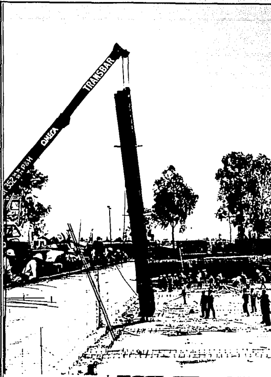
MONTAJE Y COLOCACION DE ESTRUCTURA METALICA
