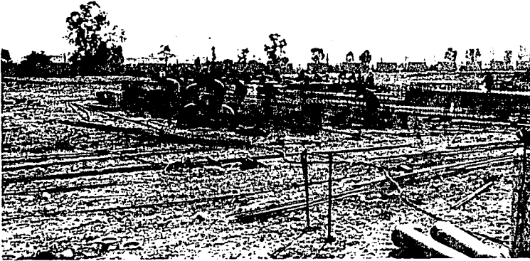
A R M A D O Y C I M B R A D O D E P I L O T E S
