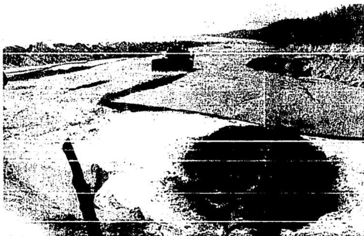
Figura 12.- Disposición de tubería flotante de descarga para darle mayor movilidad lineal y angular durante el dragado, la enorme "S" que forma la tubería flotante de la draga es con el objeto de darle movilidad, así como línea de tierra de la tubería de descarga.
