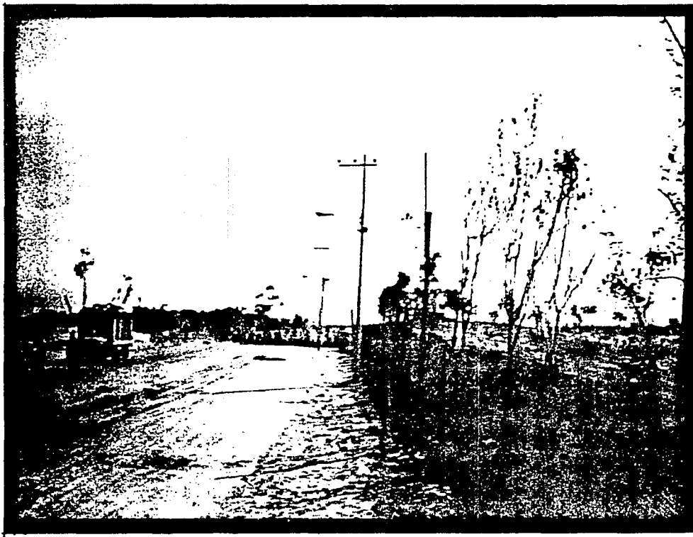
1. Vista Sur de la Av. Prolongación Reforma.
