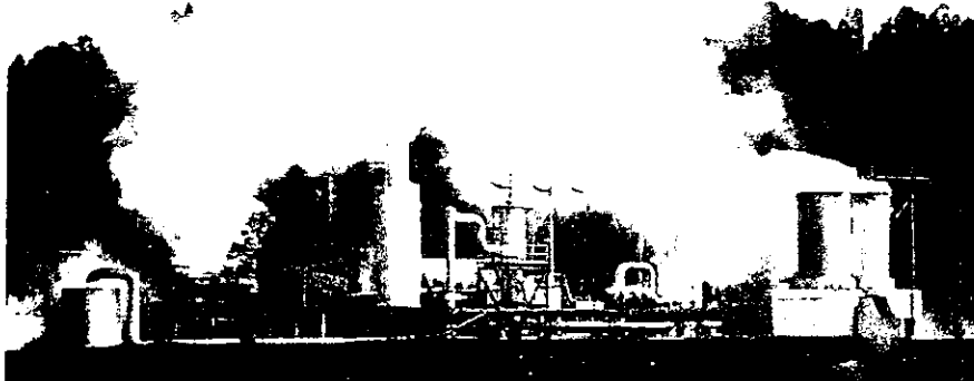
Planta geotérmica "Los Azufres"
