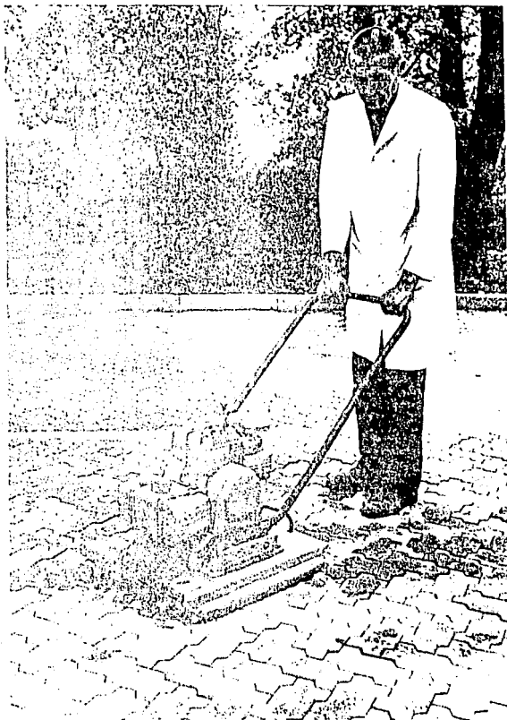
Uso de una placa vibradora para compactar el adoquinado.
