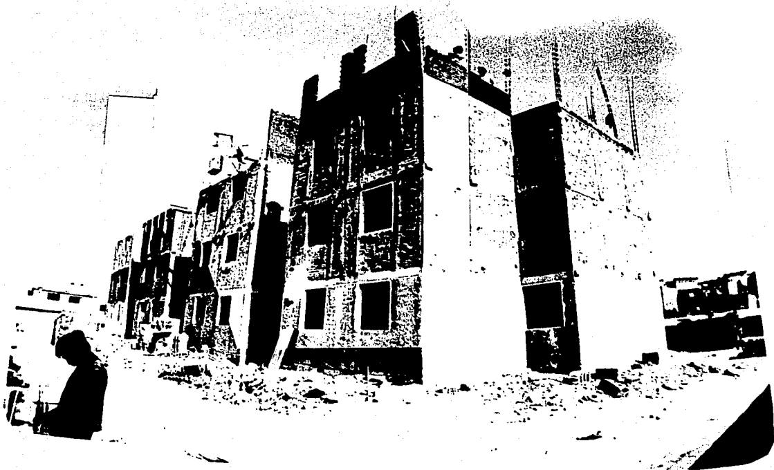
VISTA PANORAMICA DE LA CONSTRUCCION DEL MODULO 1
