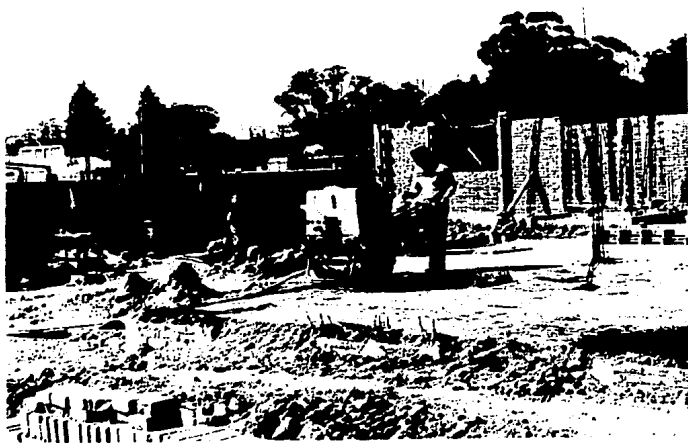
1) RODILLO LISO VIBRATORIO PARA COMPACTAR Y AFINAR... RELLEADO DE PISOS DE PLANTA BAJA
