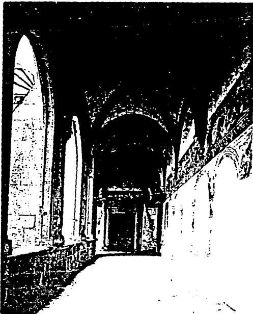
Fig. 180. Arriba: claustros alto y bajo de Ixmiquilpan. Como en Actopan, la sillería en cantera rosa forma arcos ojivales en la planta baja y de medio punto en la superior.
