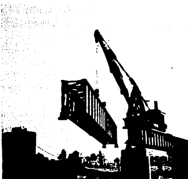
Fabricación y montaje de tramo de puente para ferrocarril.
