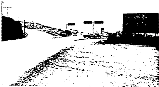
Foto 2. Otra vista del entronque en que se aprecia mejor el desnivel del terreno, además de - la rama donde se construye el libramiento de Parral.
