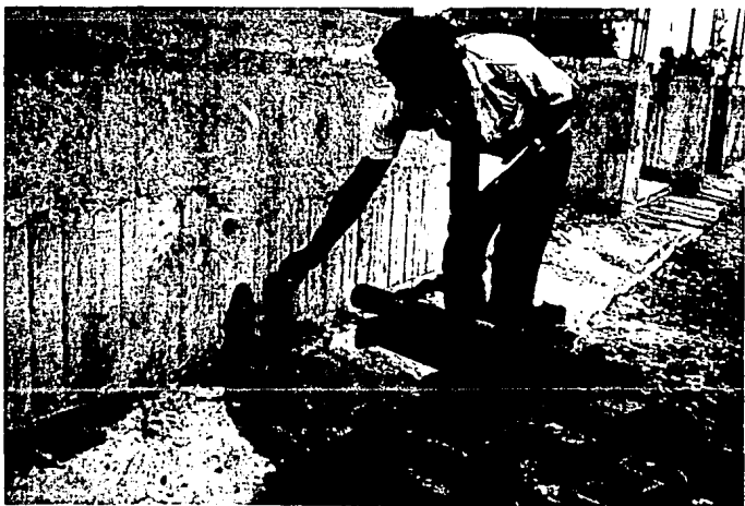
Fotografía VI.7 MAQUINA PORTATIL PARA EXTRACCION DE MUESTRAS CILINDRICAS DIRECTAMENTE EN EL CONCRETO ENDURECIDO.
