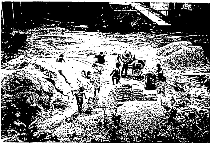
Fotografía VI.6 PRODUCCION DE CONCRETO EN EL SITIO DE LA CONSTRUCCION.
