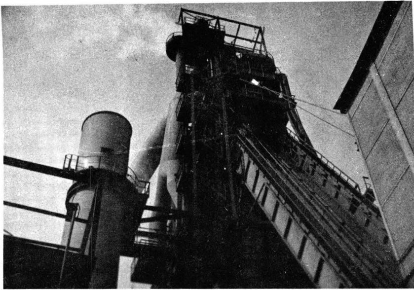
Foto 1. Inclinado, rampa para subir los materiales al Tragante del horno.
