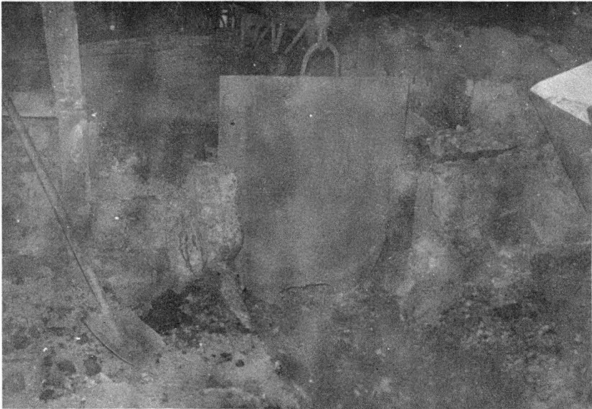
Compuerta principal del piso de vaciada.
