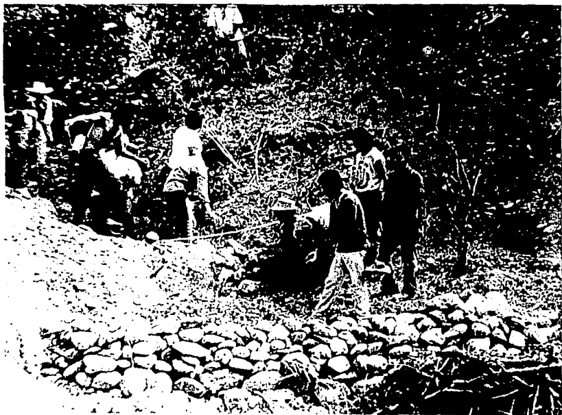
FOTO 1. CONSTRUCCION DE LOS CHECK DAMS O TERRAZAS DE CAUCE TIPO LAMA-BORDO EL DIA 12 DE MAYO DE 1989.
