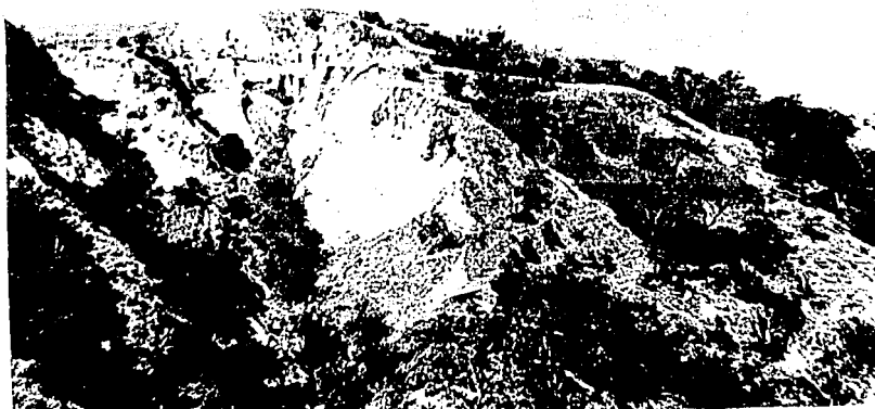
FOTO 15. EROSION REMONTANTE POR CAUSA DEL PASTOREO SOBRE TORAS Y YESOS. TLAHUAACAN, GRO.
