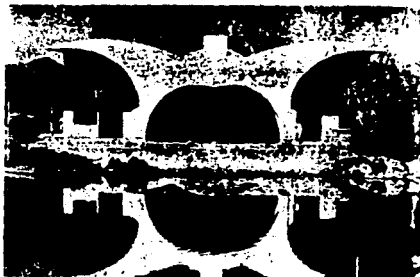
Fig. I.19 Casa-habitación construida con FERROCEMENTO del tipo particular.
