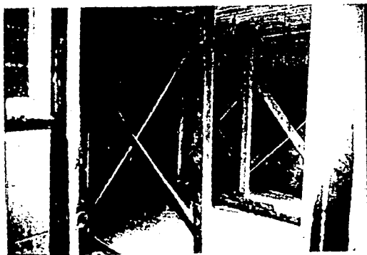
Fig. IV.4. Vista general de apuntalamiento tipo.
