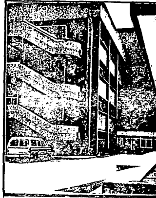
VISTA EXTERIOR DE HOSPITALIZACION
