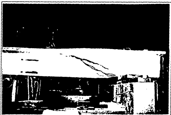
Agrietamiento por tensión principal
