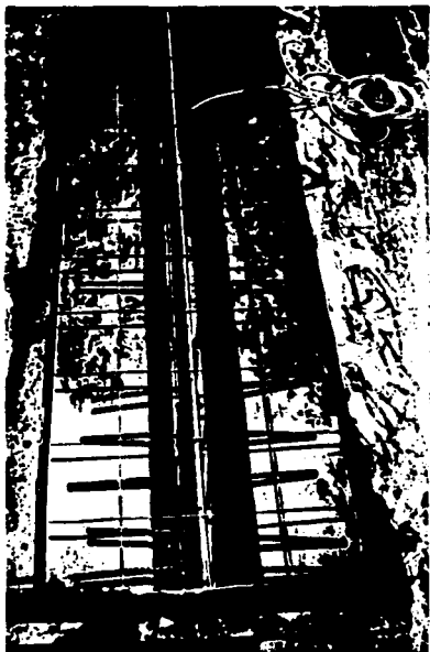
fig. 3.4. Distribución de estribos en los extremos.
