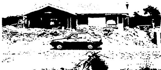
CASA CUBIERTA CON PAMAÇON, IMPERMEABILIZANTE Y TEJA.
