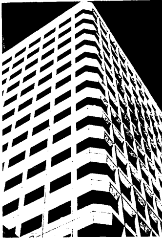
FIG. II.69 FACHADA DE PANELES PERFORADOS INDIVIDUALES
