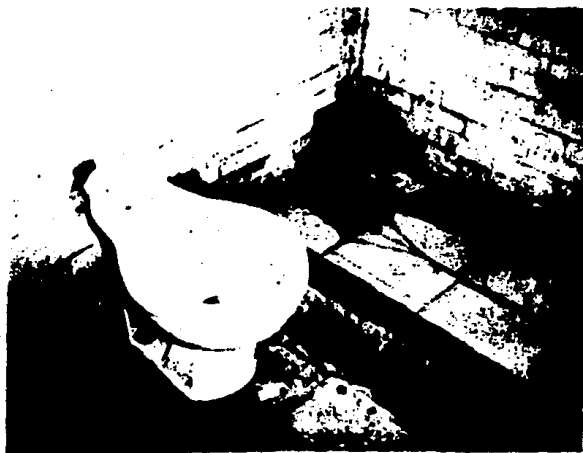
TOMA No. 7 HABITACIONES PARA LA VISITA INTIMA DEL RECLUSORIO (NOTESE LAS DEFICIENCIAS EN EL MOBILIARIO Y LAS CONDICIONES DE IN-SALUBRIDAD)
