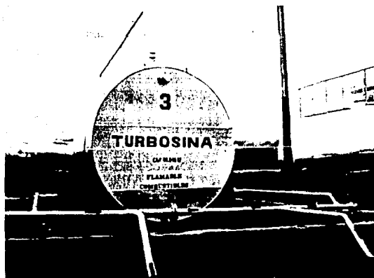
Tanque de Almacenamiento de Turbosina. Fotografía 5.5
