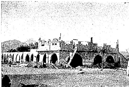
MERCADO EN CONSTRUCCION.
