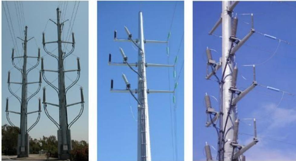
**Figura 2.10 Postes de transición troncopiramidales.**
