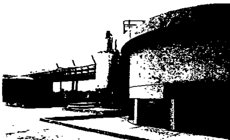
Planta de Tratamiento de Aguas Residuales Lerma Estado de Mex. (Bayer)
