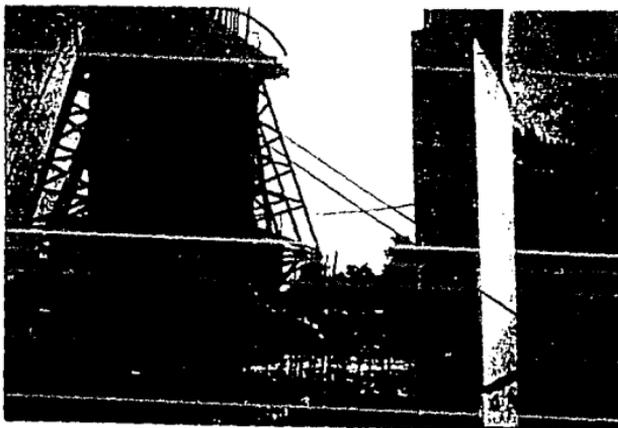
Tanto columnas como cabezales fueron colados con concreto premezclado  $f'c=350 \text{ Kg/cm}^2$ , utilizando bombas de concreto para su colocación.
