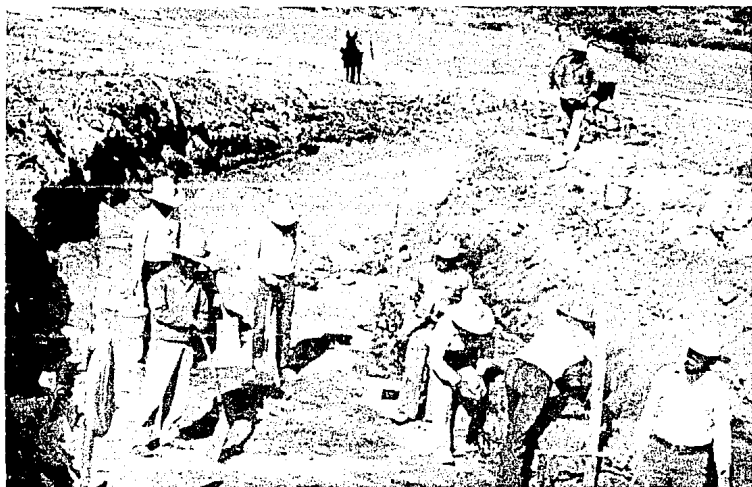
CONSTRUCCION DE CANAL PARA RIEGO
