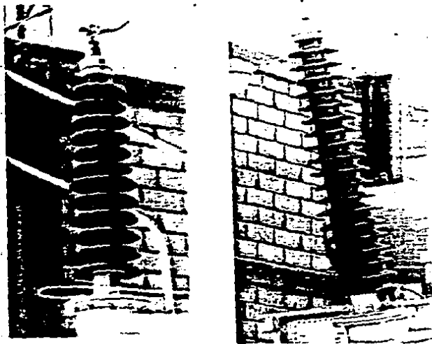
FIG. I.23: BOQUILLA X 1 , CLASE 138 KV, (Izq.) Y BOQUILLA H 1 , CLASE 230 KV, (Der.), MARCA MICAFIL.
