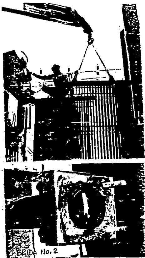
FIG. 11.2 : COLOCACION DE LOS RADIADORES EN SUS BRIDAS CORRESPONDIENTES RADIADOR A, EN BRIDAS 1 Y 2 .
