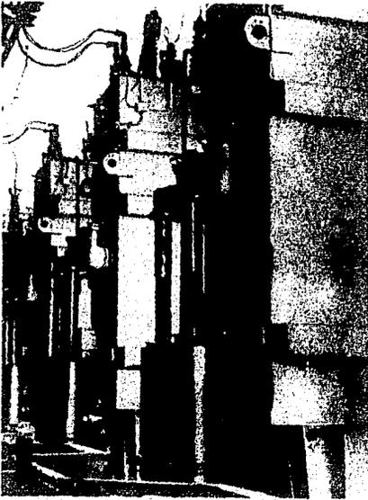
Figura No. 6.- Equipo de enfriamiento por circulación forzada de aceite.
