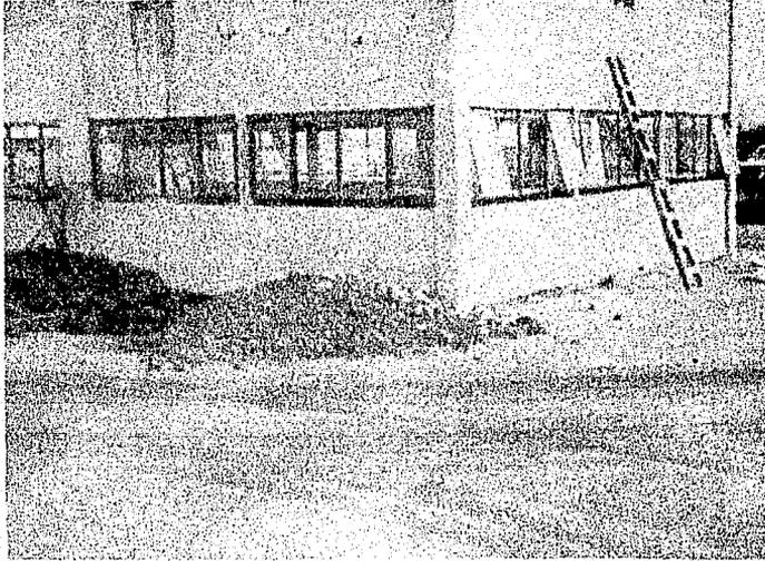
FOTO No. 29 Muro de block ó tabique aplanado por cara exterior.
