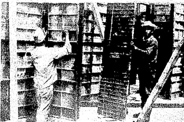
FOTO No. 1 Cimbrado de un muro en planta baja.
