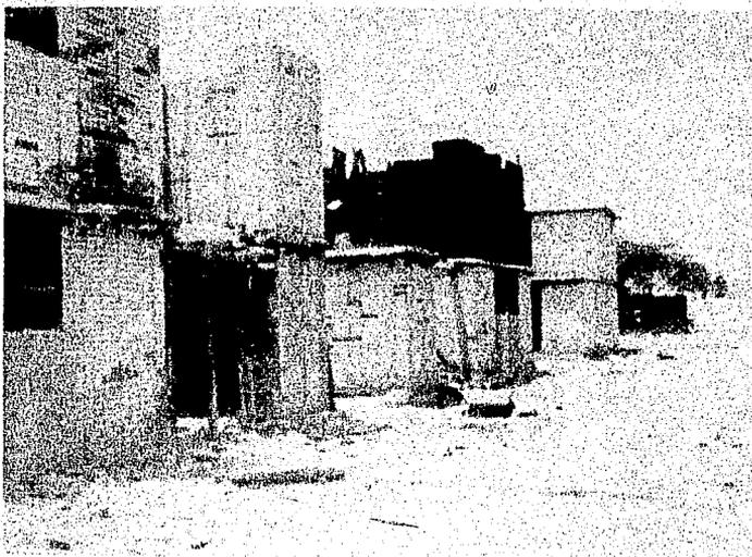
FOTO No. 13 Vista de una zona de trabajo en la cual se aprecia en los muros, los resanes ejecutados (se ve el cambio del tono del concreto)
