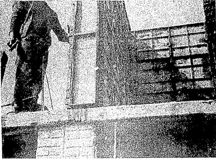
FOTO No. 5 Muro planta alta casi terminado de cimbrar.
