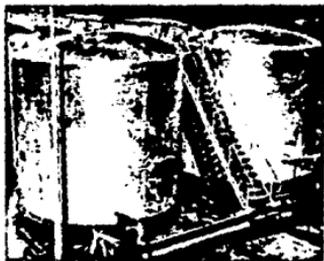
Figura 61.- Cubas de 150 m<sup>3</sup> para almacenamiento de HNO<sub>3</sub>, construidas en A8; soldadura MIG.
