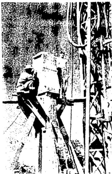
Reconstrucción de una cabeza de pilote de 40 x 70 cm, adaptada a sección cuadrada, después de romperse durante el hincado.
