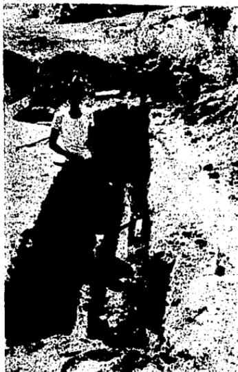
Detalle de una de las paredes de la ataguía terminada de hincar; nótese el buen alineamiento de las piezas y su buena conservación después de haberlas hincado dos veces.
