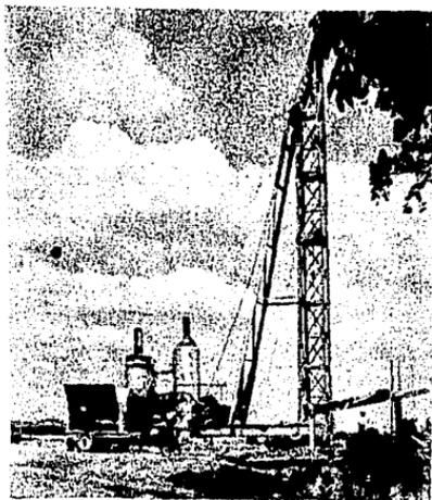
Máquina pilotadora sobre rolos con torre metálica dividida en dos tramos con conexiones sumamente fáciles.
