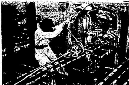
Bajando las pilotes armados a descansar en los moldes para el fondo de los mismos, luego se colocan los costados.
