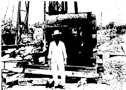
Bomba de cuatro pasos de alta presión para inyección de agua a los chiflones.
