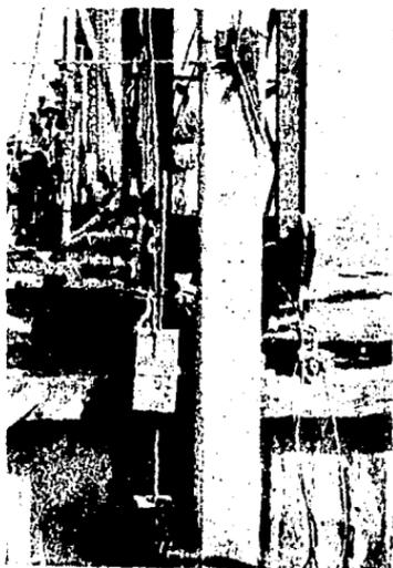
Dispositivo para el hincado del tubo con chiflón lateral, la guía del martillo de gravedad, construido ex-profeso, la constituye un tubo de 1" que pasa a través de él; se suspende de la torre de la piloteadora y se opera con la propia maquinaria usando los retornes o cabesa de negro de uno de los malacates, por fricción.
