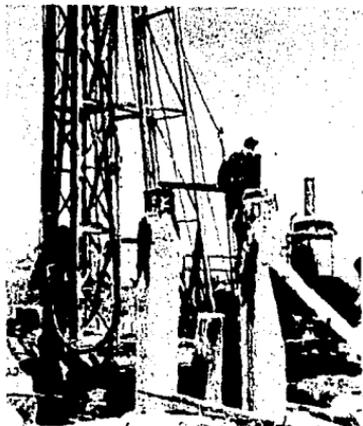
Pilotes con la cabeza destruida debido a la obstrucción del chiflón; hubo necesidad de reconstruirlos e inyectar el agua mediante chiflones laterales.
