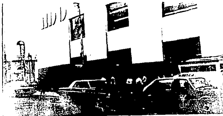
Fotografía No. 8.- Vista parcial de la Terminal ADO del lado sur. ( acceso ) .
