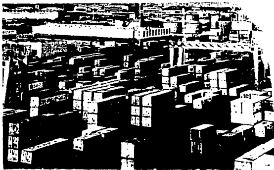
Uso de grúas-pórtico en un patio de contenedores.
