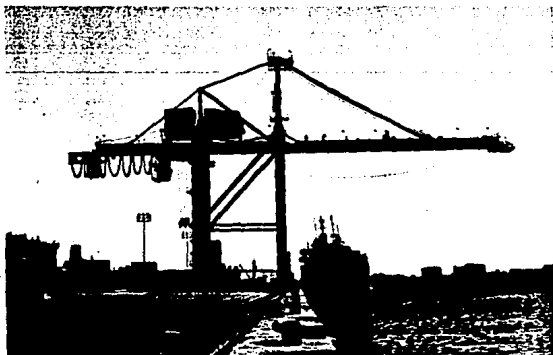
Grúa pórtico en el muelle de contenedores en el puerto de Veracruz
