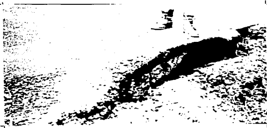
Zona socavada en la Carretera de Concreto.
