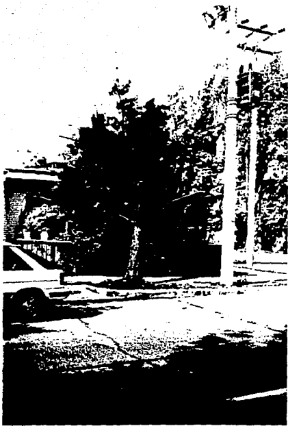
Fot. N o 9. Problemas sobre el cableado (luz. - teléfono).
