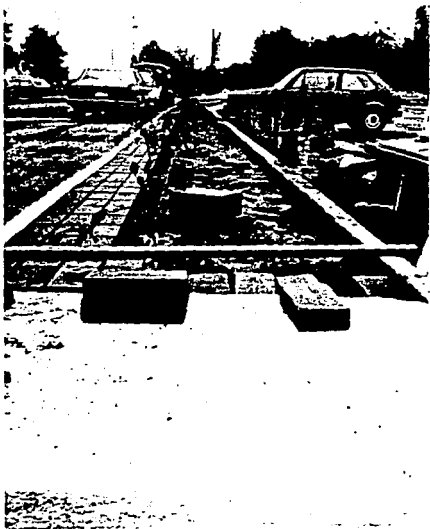
Fot. N o 14. En ésta se puede apreciar el momento del adoquinado a fin de aislar el suelo de los agentes atmosféricos -- (lluvia).
