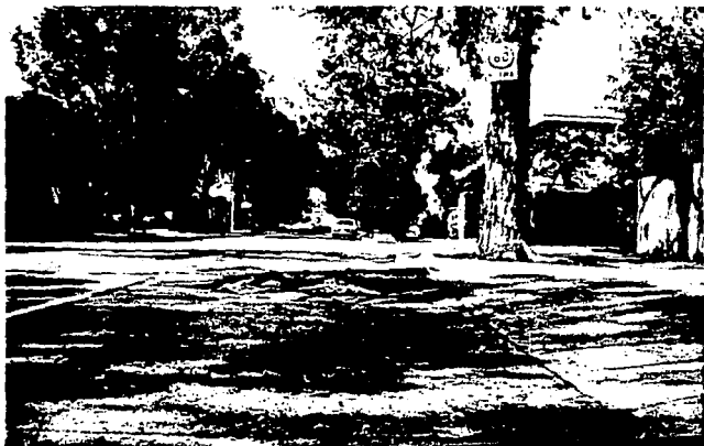
Fot. N o 11. Destrucción de pavimentos.
