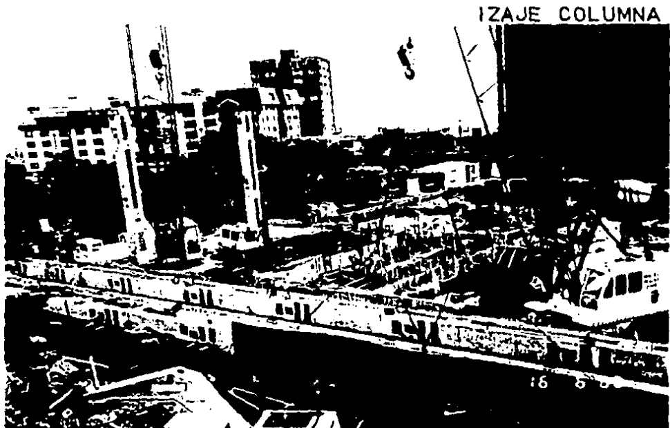
COLUMNA PREFABRICADA AL PIE DE OBRA BARRENOS CONEXION TRABE PORTANTE
